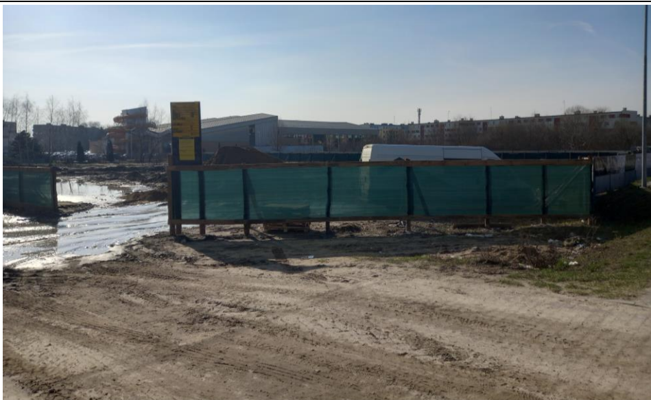
Zdjęcie 3. Widok z ul. Koszarowej na teren budowy bloku mieszkalnego w centralnej części obszaru objętego mpzp
