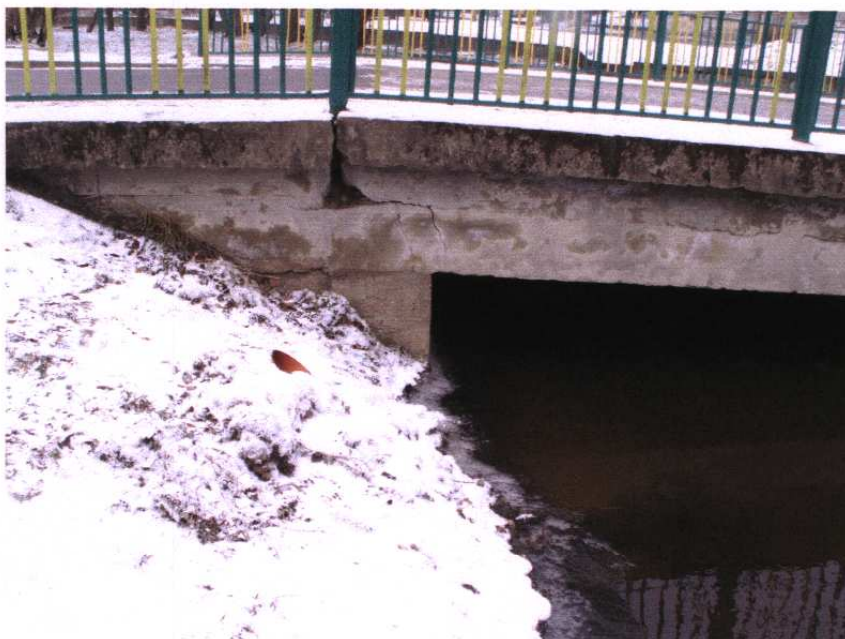
Fot. 16. Pęknięcia w strefie podporowej przęsła nad przyczółkiem lewobrzeżnym po stronie górnej wody.
