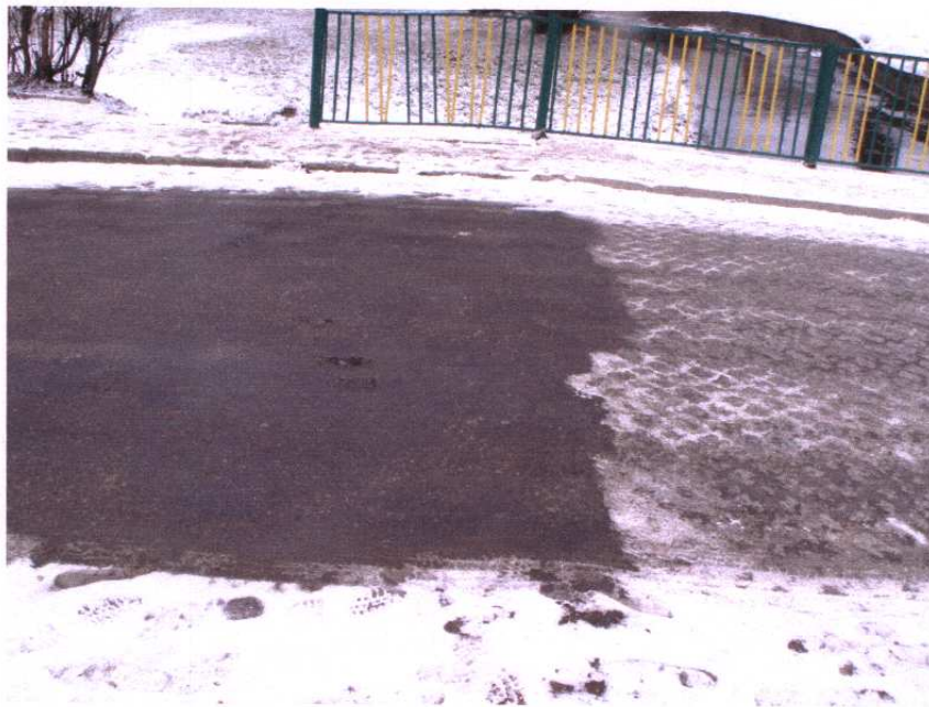
Fot. 15. Zmiana rodzaju nawierzchni: asfalt na dojeżdże/kostka kamienna na moście.
