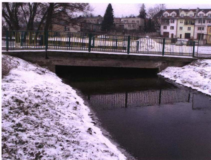
Fot. 1. Widok z boku od strony górnej wody.
