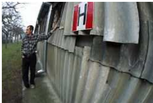
Rysunek 7 Znaczne uszkodzenia powierzchni azbestowych płyt falistych na dachu budynku:
