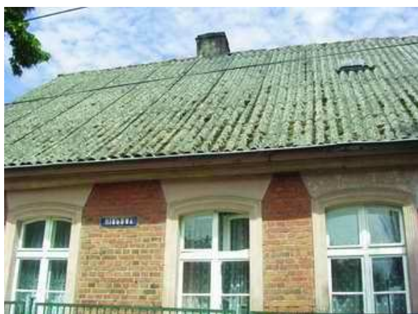
Rysunek 6 Ściana boczna budynku z płyt cementowo-azbestowych:
