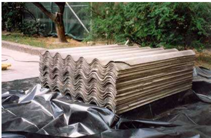
Rysunek 4 Przygotowanie wyrobów azbestowych do transportu:
