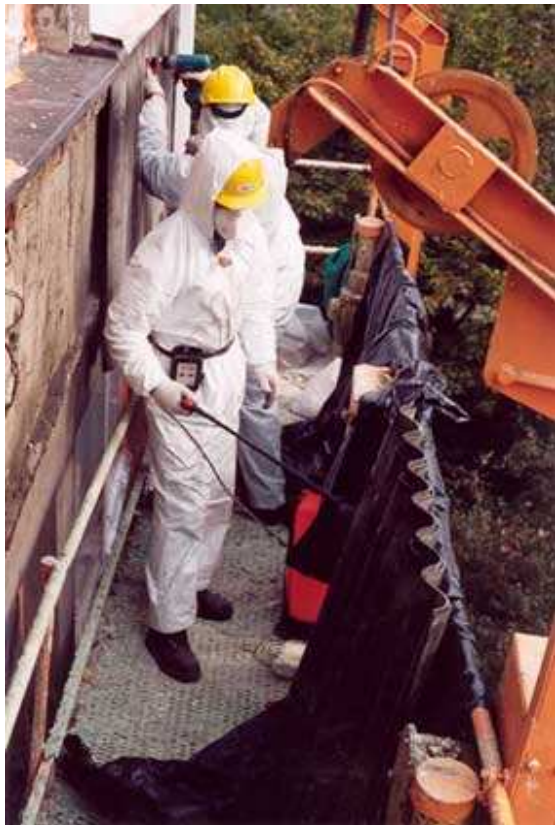
Rysunek 3 Usuwanie wyrobów azbestowych:
