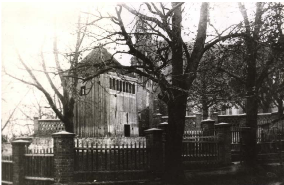
Fot. 8. Stara drewniana dzwonnica przed Kościołem Świętej Trójcy, ze zbiorów MZD
