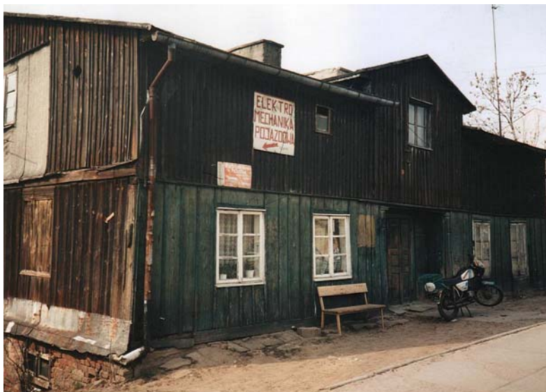
Fot. 28. Przykład drewnianego budynku przy ulicy Pilsudskiego 15, rozebrany
