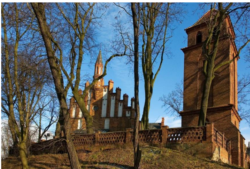
Fot. 9. Widok od strony mostu na Rypienicy na Kościół Świętej Trójcy i Dzwonnicę, foto Maciej Bagiński, ze zbiorów MZD
